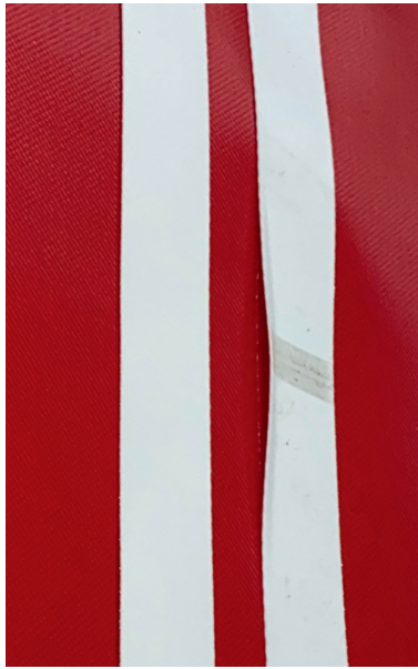
Reparaturmaterial nach Zuschnitt
