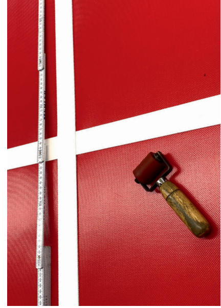
Nach sachgemäßer Instandsetzung Reparaturmaterial im Zuschnitt
