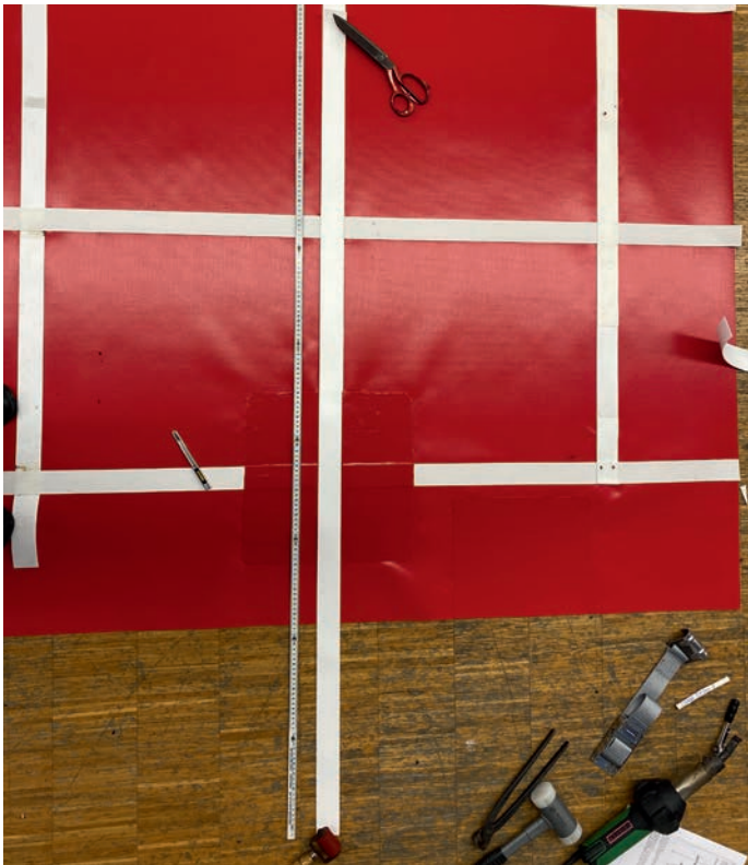
Reparaturmaterial nach Zuschnitt
