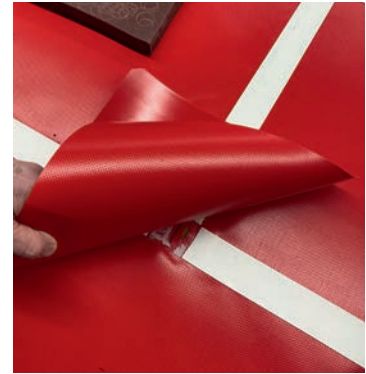
Reparaturmaterial nach Zuschnitt
