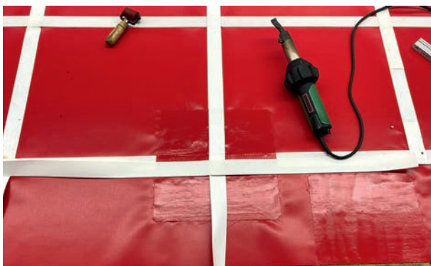
Reparaturmaterial nach Zuschnitt
