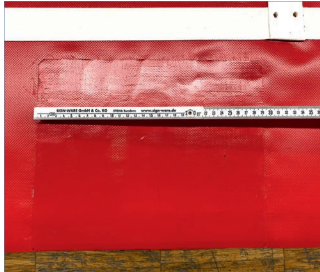
Nach sachgemäßer Instandsetzung Reparaturmaterial im Zuschnitt
