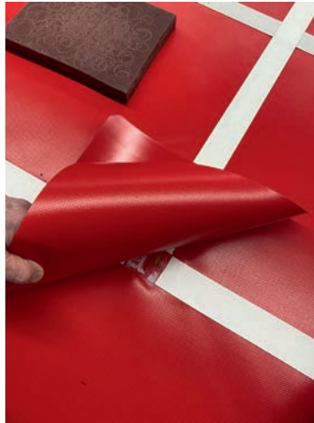
Reparaturmaterial nach Zuschnitt
