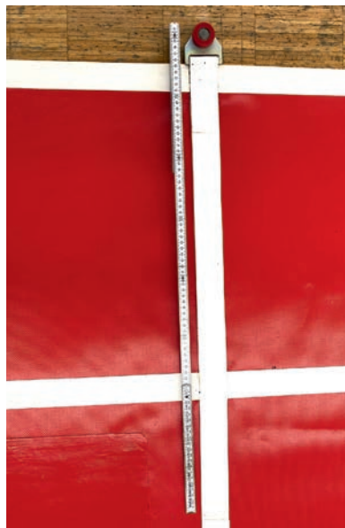
Nach sachgemäßer Instandsetzung Reparaturmaterial im Zuschnitt
