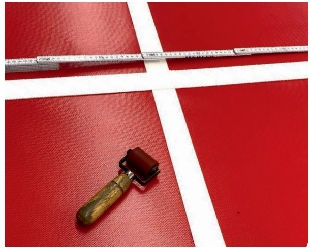
Nach sachgemäßer Instandsetzung Reparaturmaterial im Zuschnitt
