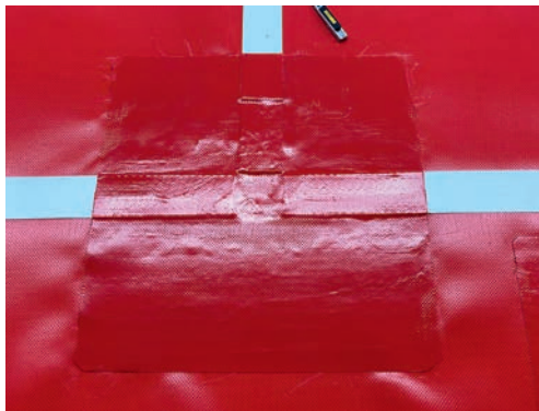
Nach sachgemäßer Instandsetzung Reparaturmaterial im Zuschnitt
